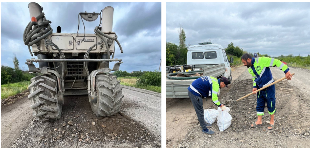
Рис. 1. Отбор проб щебеночного материала основания на автодороге Сватово — Новопсков — Меловое км 132+311 — км 168+111 в Луганской Народной Республике РФ
